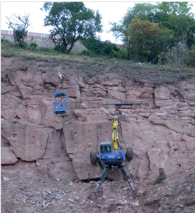
Bild: Schreitbagger an der Felswand
